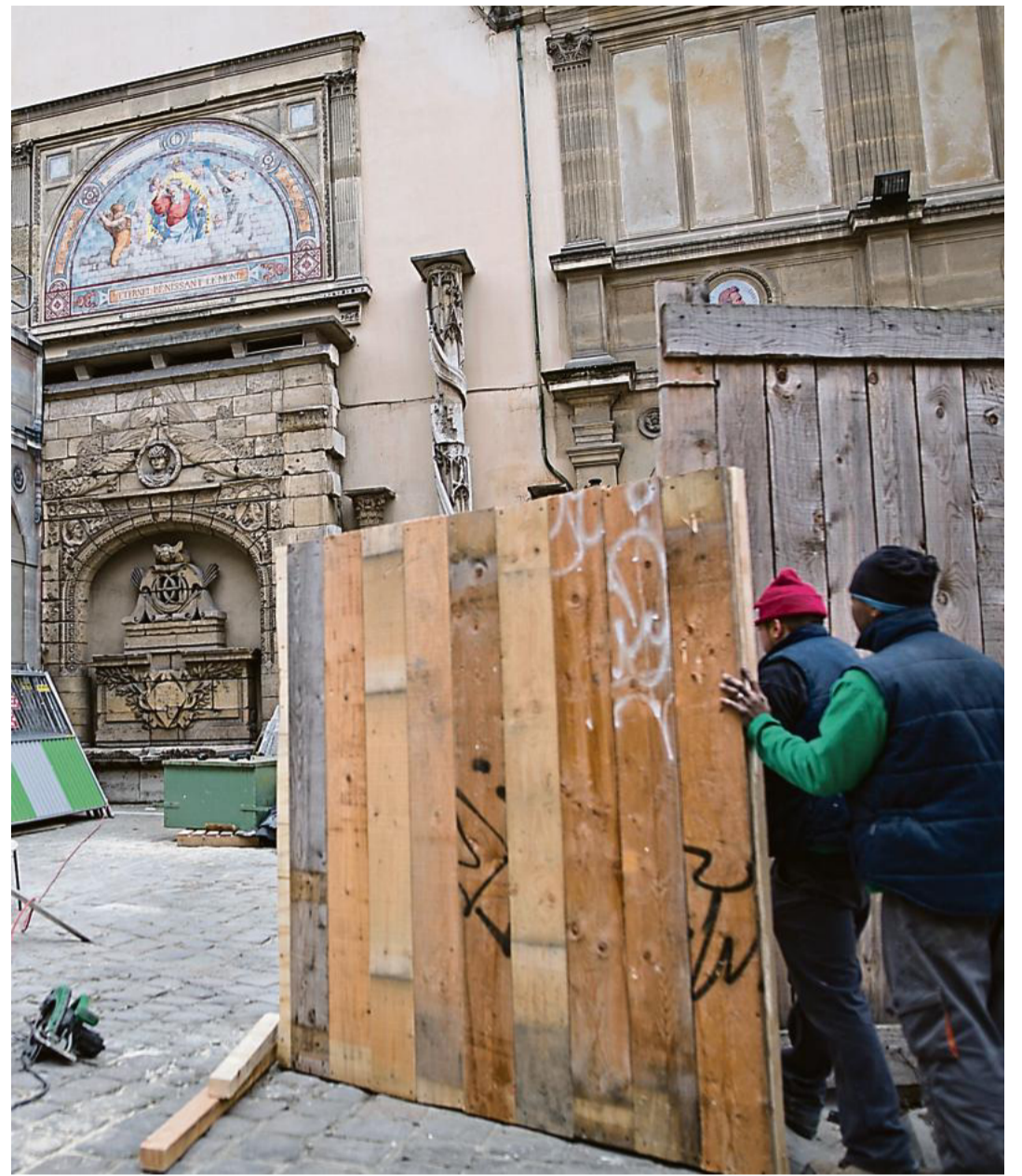
L'Etat a déjà engagé 3,8 milliards d'euros dans la rénovation énergétique de son parc immobilier (ici l'Ecole nationale supérieure des beaux-arts de Paris) depuis 2019. Photo Anthony Macalfe/Haytham-REA
